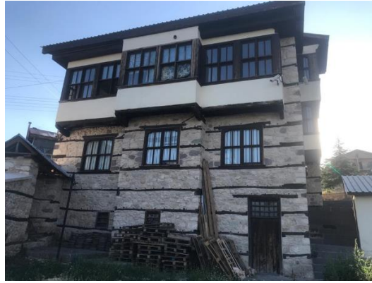
Foto.2- Arapgir Kaşkal Konağı Doğu Cephe.
