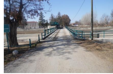
Çarşamba Çayı Köprü Döşemesi
