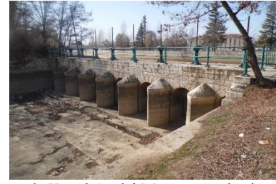
2. Kanal Geçişi Mansap Cephesi
