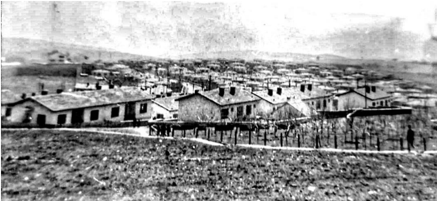
Resim 11. Safranbolu 69. Alay Binaları'nın Güneyinde Emek Mahallesi'ne İnşa Edilen Demirçelik Fabrikası'nın İşçilerine Ait 44 Evler (Tevfik Kuzu ve Mehmet Gökçü Arşivi, 1969)
