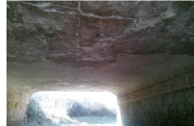
Betonarme Köprü Döşemesi
