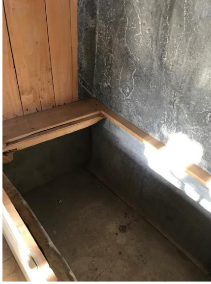
Foto.13- Arapgir Kaşkal Konağı Dolap Kehrizi.
