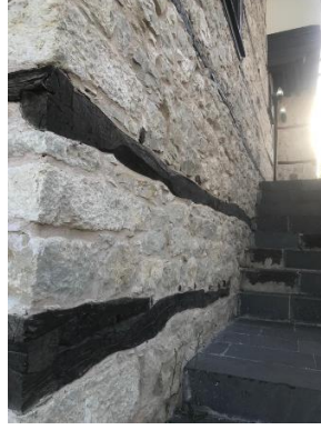
Foto.7- Arapgir Kaşkal Konağı Kuzey Cephe Duvarına Bitişik Taş Basamaklı Merdiven.
