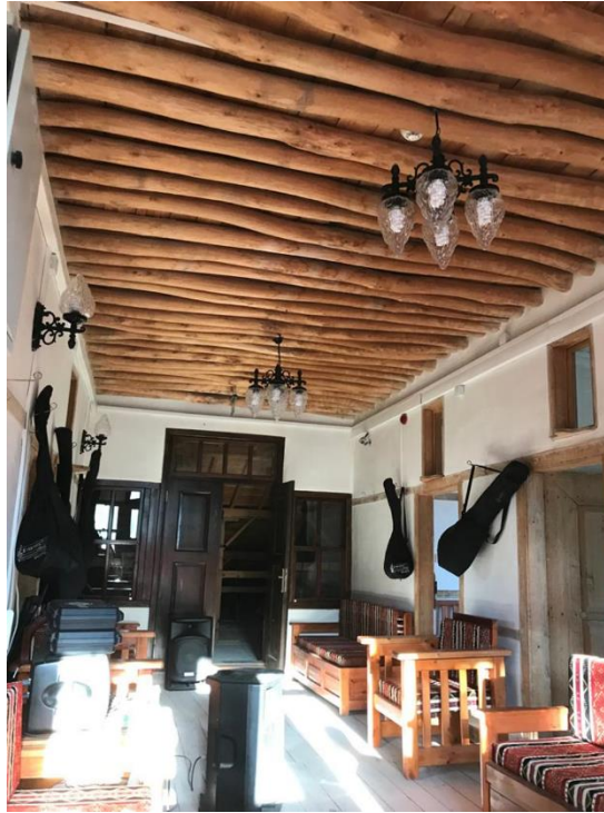
Foto.16- Arapgir Kaşkal Konağı'nda İç Sofa Düzeni ve Örtü Sistemi.
