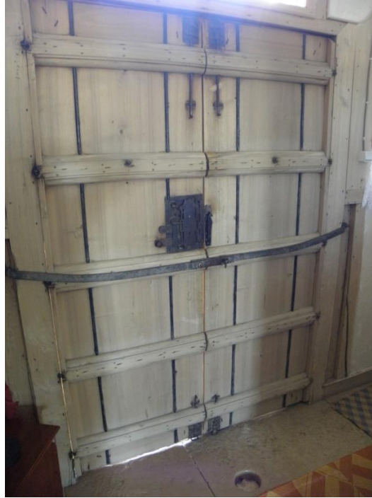
Foto.5- Arapgir Gültekin Konağı Giriş Kapısının Demir Kilit ve Kenet Sistemi
