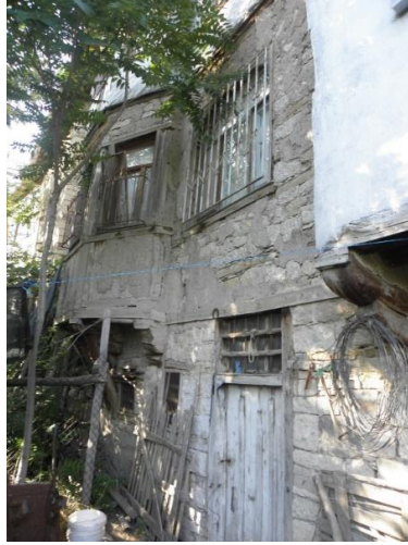
Foto.15- Gültekin Konağı Güney Cephe.
