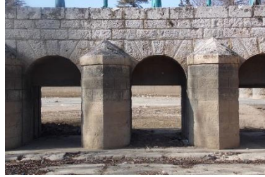
2. Kanal Geçişi Mansaptan Detay
