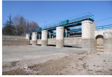
Çarşamba Çayı Mansap Cephesi
