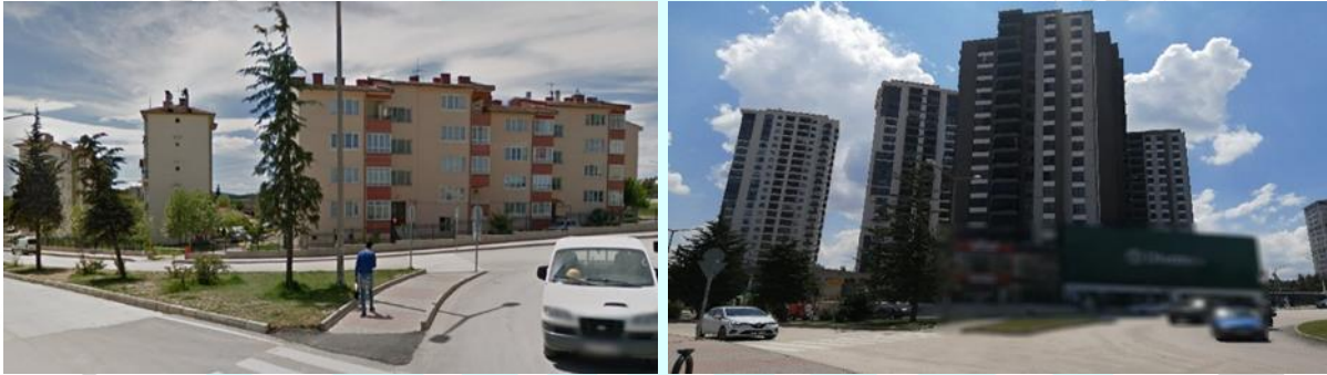
Görsel 2. Çalışma alanı dönüşüm öncesi ve sonrası
